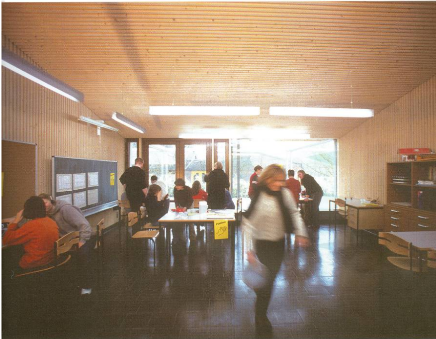
Les surfaces rainurées des murs et des plafonds participent à une meilleure acoustique des salles de classe
