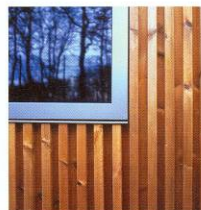
Détail du revêtement extérieur qui reprend la même texture que le matériau de structure
